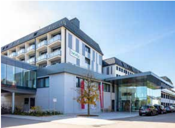
Abb. 5 Außenansicht des RZ Austria
