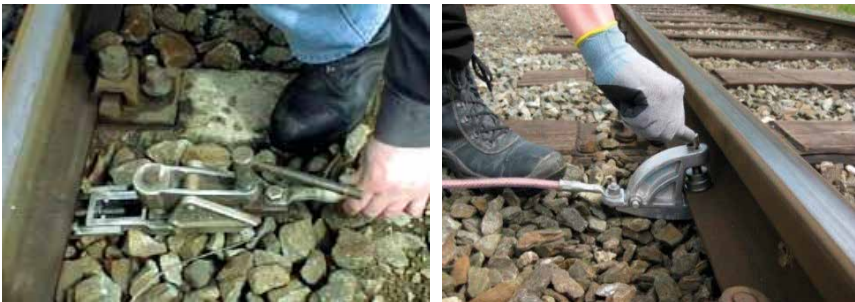
Abbildungen 20a und 20b: Befestigen der Schienenfußerdungsklemme
