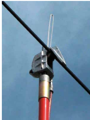
Abbildung 23: Einhängen der Fahrdrahterdungsklemme
