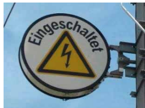
Abbildungen 12a und 12b: Schaltzeiger „Oberleitung des Ladegleises ist eingeschaltet“
