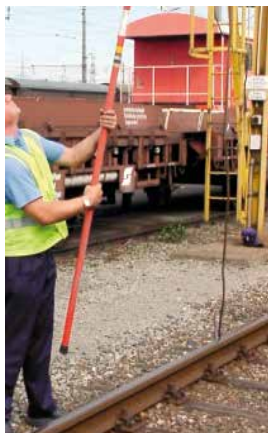
Abbildung 21: Aufrichten der Erdungsstange
