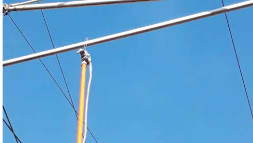
Abbildung 22: Feststellen der Spannungsfreiheit mit Prüfspitze
