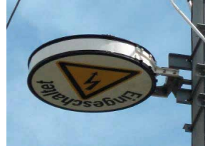
Abbildungen 13a und 13b: Schaltzeiger „Oberleitung des Ladegleises ist ausgeschaltet“
