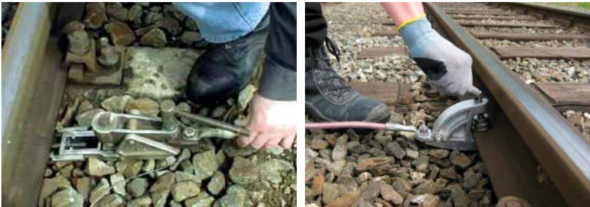
Abbildungen 20a und 20b: Befestigen der Schienenfußerdungsklemme
