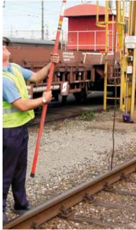
Abbildung 14c: Aufrichten der Erdungsstange
