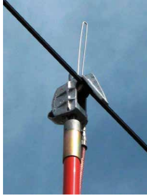
Abbildung 14f: Einhängen der Fahrdrahterdungsklemme
