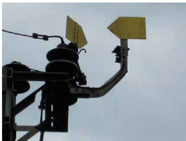
Abbildung 13b, 13c, 13d, 13e, 13f und 13g: Schaltzustand „eingeschaltet“: Schaltzeiger (Trommel) zeigt „eingeschaltet“, Stellungszeiger (2 gelbe Pfeile) zeigt „nicht geerdet“
