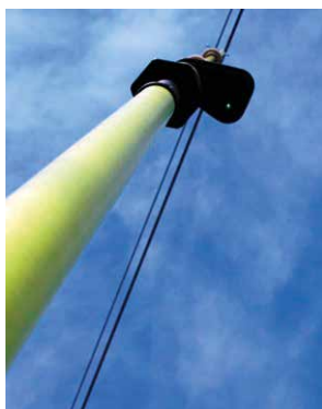
Bild 14d und 14e: Feststellen der Spannungsfreiheit mit Spannungsprüfer bzw Tastspitze
