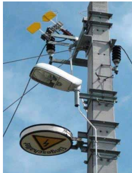
Abbildungen 13h, 13i und 13j: Schaltzustand „ausgeschaltet“: Schaltzeiger (Trommel) zeigt „ausgeschaltet“, Stellscheibe (2 gelbe Pfeile) zeigt „geerdet“
