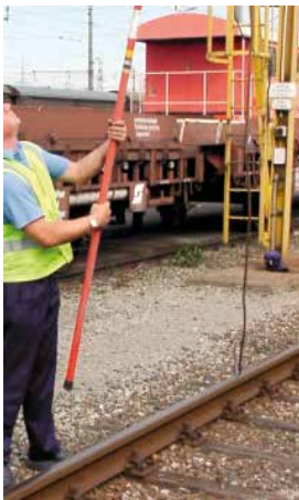
Abbildung 14c: Aufrichten der Erdungsstange
